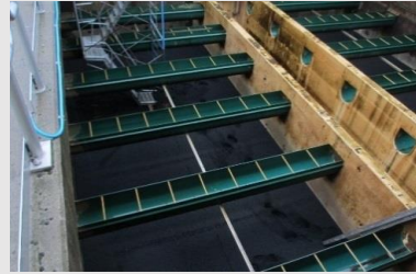
急速ろ過池(更生工事中)
