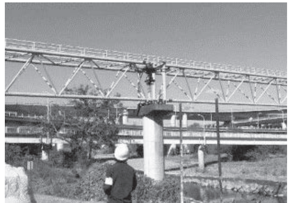
写真 ドローン点検状況
