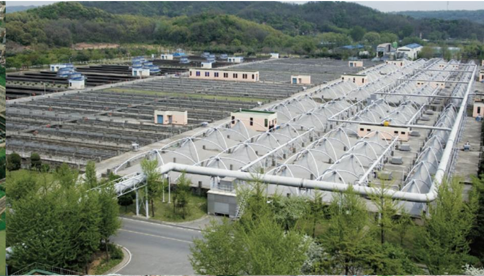
Nan Ji WWTP 0.86 M m 3 /day
