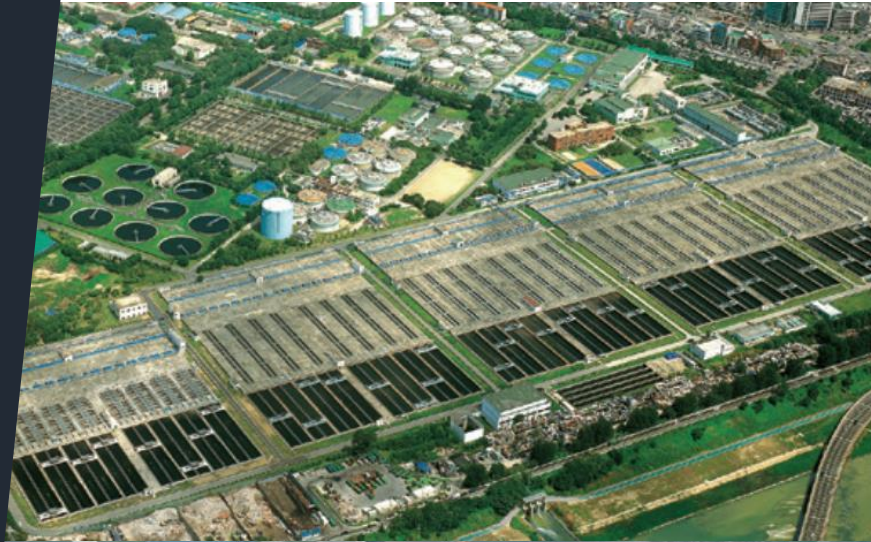
Joong Rang WWTP 1.60 M m 3 /day
