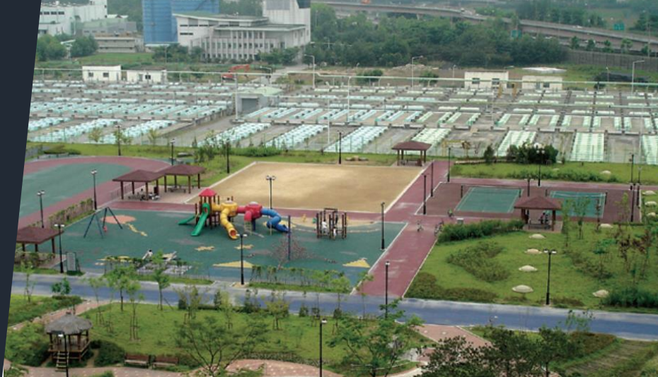
Tan Chun WWTP 0.90 M m 3 /day
