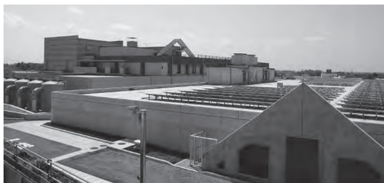
川井浄水場「セラロック」
