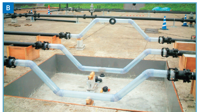
B 実験管路（横浜市水道局川井浄水場）
