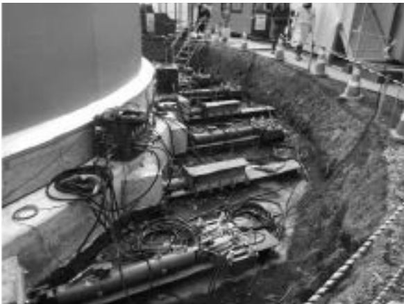
油圧ジャッキ設置状況
