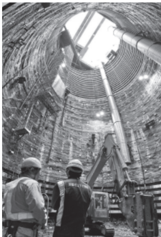
写真 発進立坑及び施工状況
