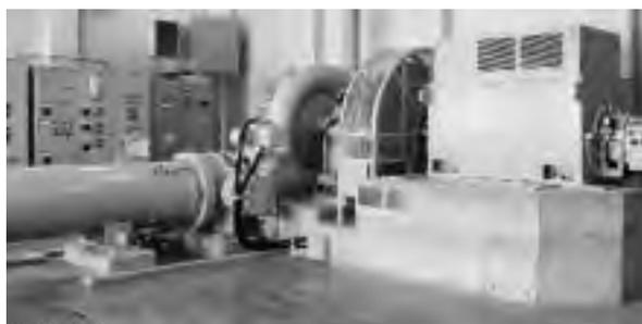
写真1 藻岩浄水場水力発電 水車
