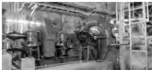
写真2 平岸配水池水力発電 水車
