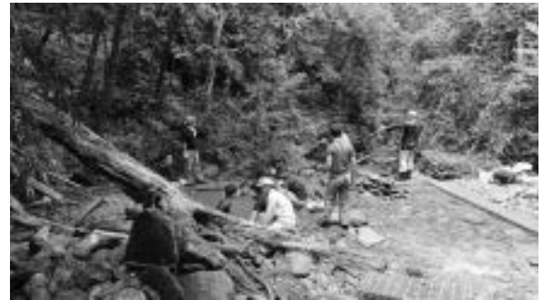
写真3 職員による土砂除去の様子
