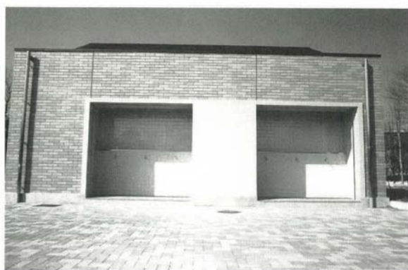
▲災害用常設給水栓 (平常時はシャッターが下りている)
