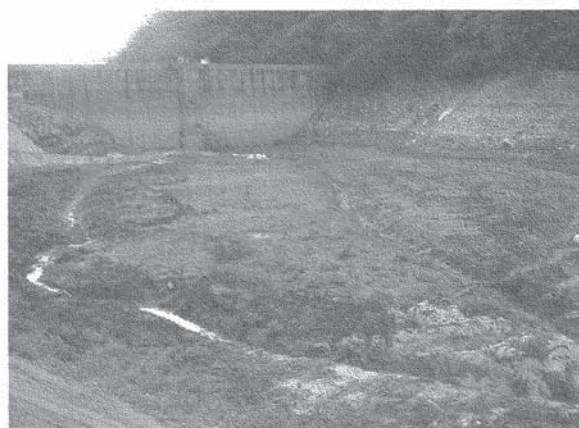
写真8 土砂撤去前の状況
