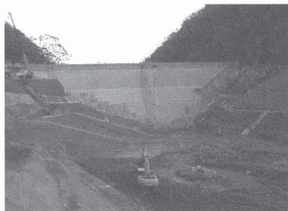
写真9 土砂撤去後の状況
