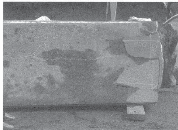
写真4 切り出したコンクリート
