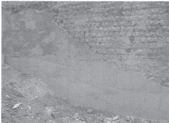
写真3 置換コンクリート
