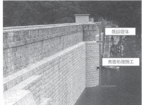
写真5 補強コンクリート表面処理
