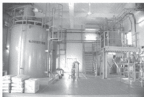
▲酸注入棟内部
