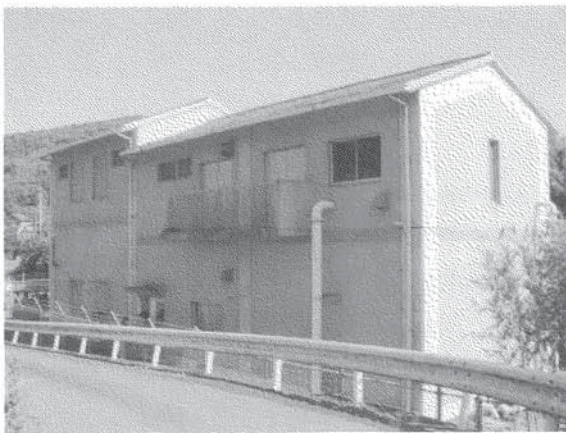
写真 4-3 四箇ポンプ場
