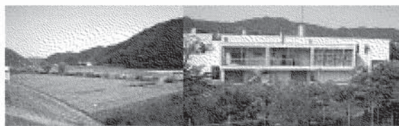
▲雄総水源地（河川敷井戸及び管理棟）
