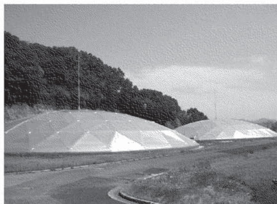
写真17 工事完了（地上から撮影）
