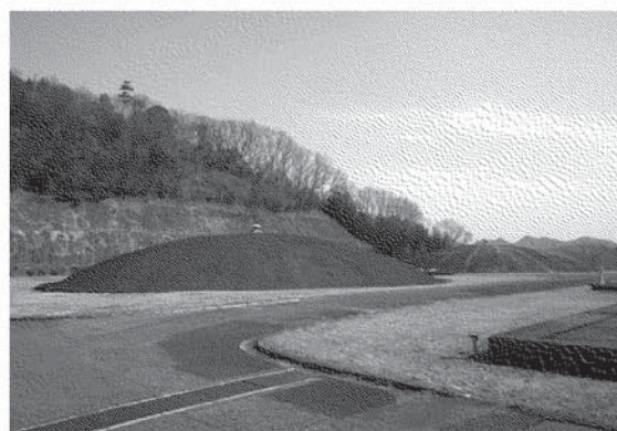
写真1 配水池（ドーム屋根）外観
