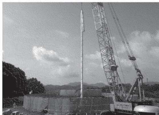
写真5 遮蔽シートの挿入
