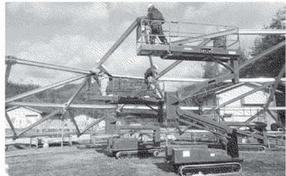
写真12 骨組材の組立
