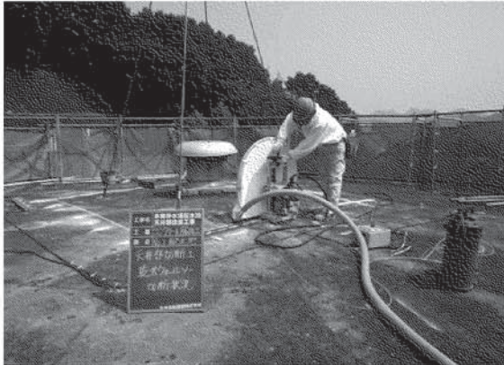
写真8 ウォールソーによる切断
