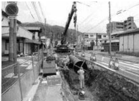
写真4 東西連絡管φ1,100鋼管布設状況
