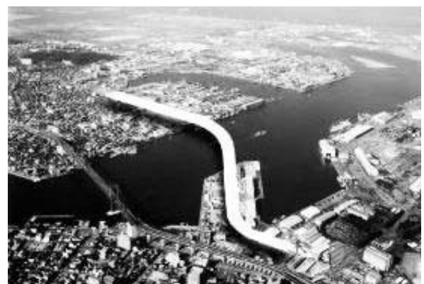
図4 新若戸道路（トンネル部）の全景
