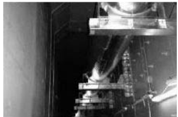
写真5 新若戸道路水道連絡管φ600 配管状況
