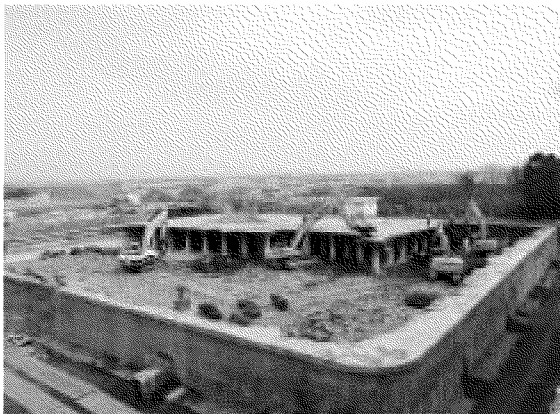
写真6 旧生田配水池の取壊し状況
