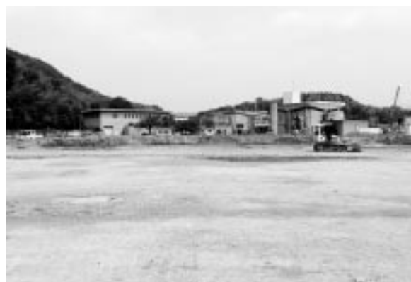
写真2 パネル設置前の配水池
