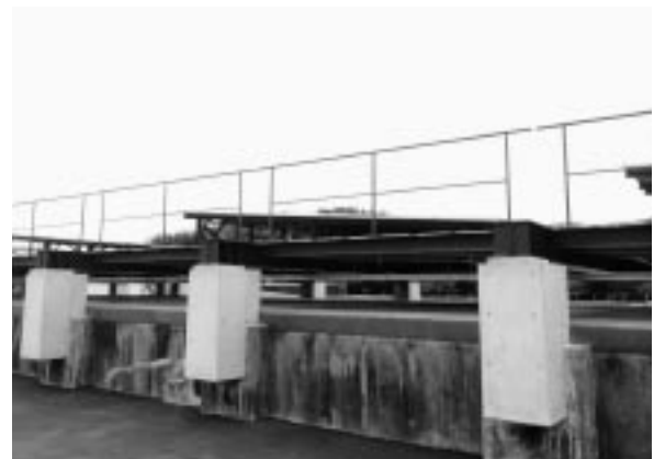
写真1 ポンプ棟上屋設置状況
