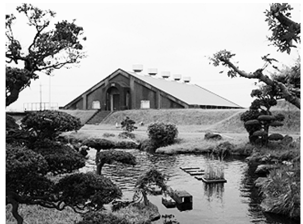
▲写真1 1号配水池
