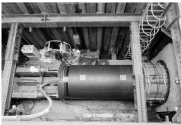
写真5 推進工法による流出管（φ1,800）の布設
