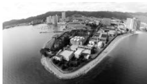
写真3 柳が崎浄水場と浄水管理センター
