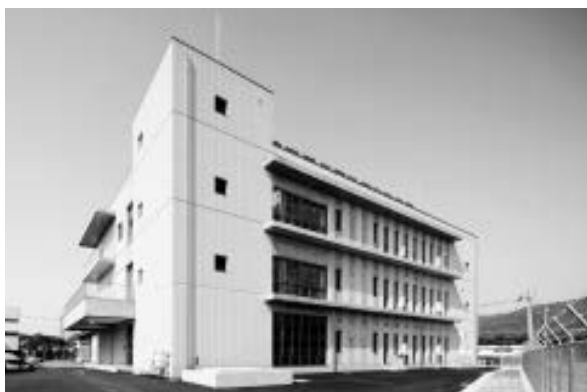
写真4 浄水管理センター 外観
