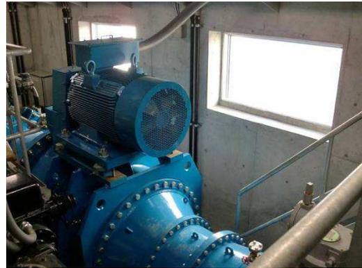
写真1 小水力発電設備（横浜市川井浄水場）
