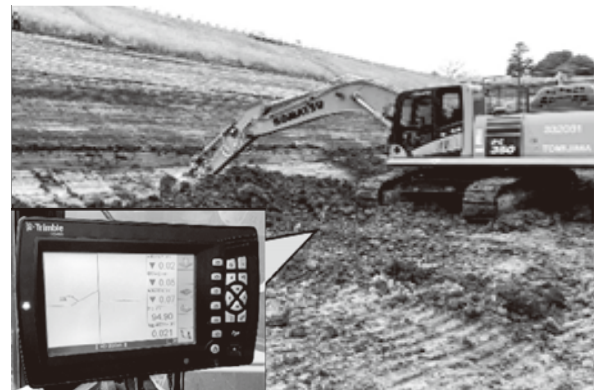
写真 ICTバックホウによる掘削状況（写真左：運転席内モニター）
