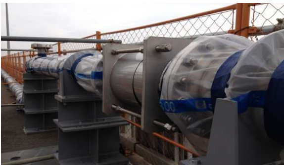
写真1 伸縮管(タイロット付)の設置状況
