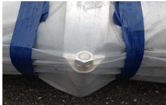
写真2 ダブルナットによる緩み防止状況
