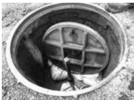
図1 鉄蓋落下状況
