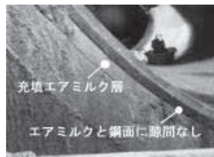
写真2 セメント系充填材（エアミルク）の充填状況
