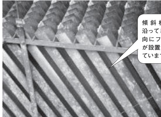
図2 フィン付傾斜板沈降装置外観
