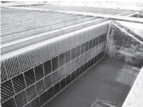
図1 平板傾斜板沈降装置外観
