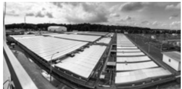
写真 西側沈澱池（覆蓋化後）
