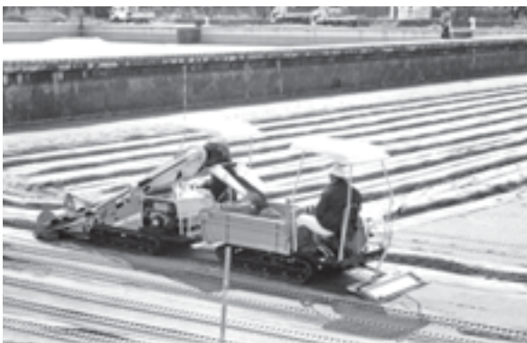
写真1 機械化した作業状況
