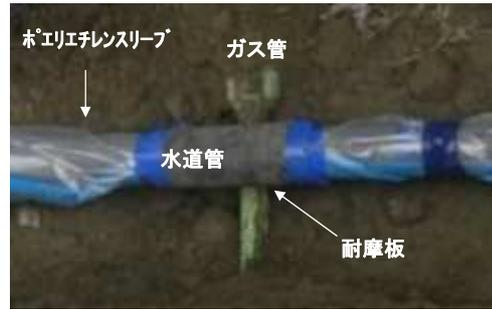
写真1 水道管布設時の耐摩板の設置状況
