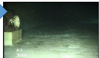
清掃後: 床面の点検が可能となる
