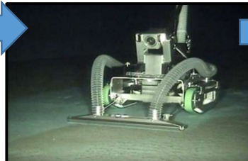
清掃中: 底版の沈澱物の吸引排出
