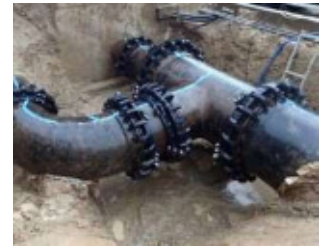
本管：K形1000,800,600mm 分岐：K形800mm
