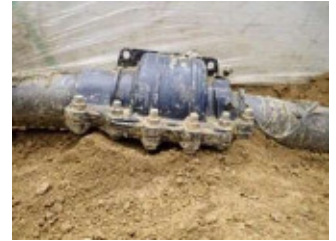
K形 150mm施工例(実験)
