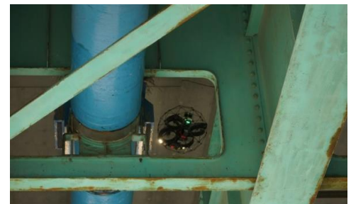
狭小部の撮影状況 (橋梁添架管)
