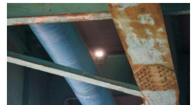
狭小部の撮影状況 (橋梁添架管)
