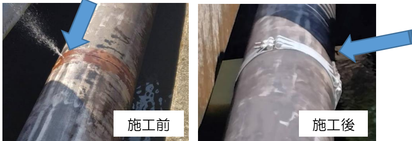
水管橋 (φ500) 施工事例
