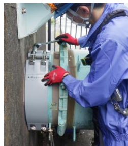
水管橋狭小スペースでの施工事例 (φ600)
