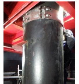
屋内配管狭小スペースでの施工事例 (φ600)
