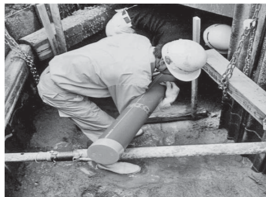
管を持ち上げての施工
