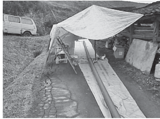
ビニールシートを利用した雨天時施工
