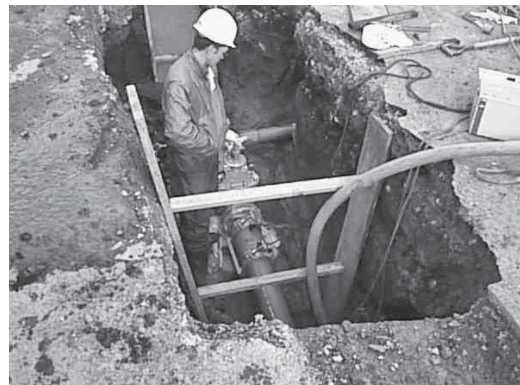
水中ポンプを用いた施工
