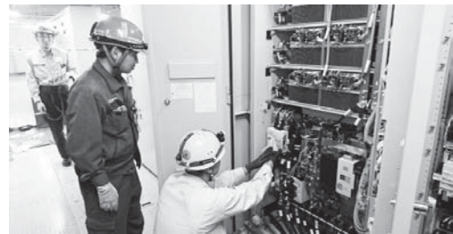
写真 点検作業の様子
