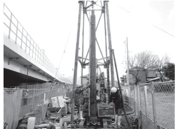
図2 ボーリング工事状況
