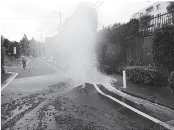
図1 破裂の状況
