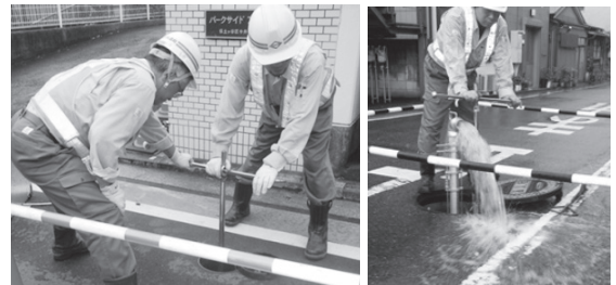
図2 仕切弁操作・洗浄
