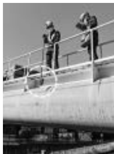
写真2 ポールカメラによる点検
