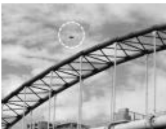
写真1 ドローンによる点検
