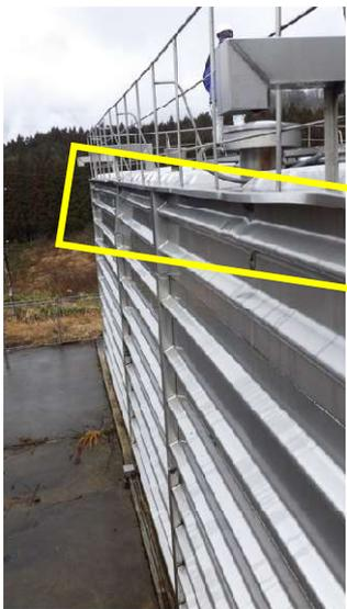
F. 補強材による突き上げ
