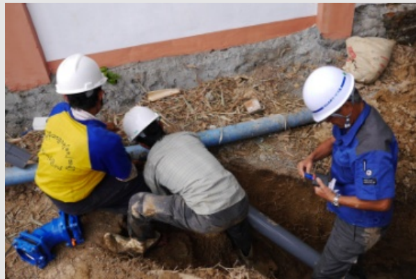
←現地で水道管を取替
